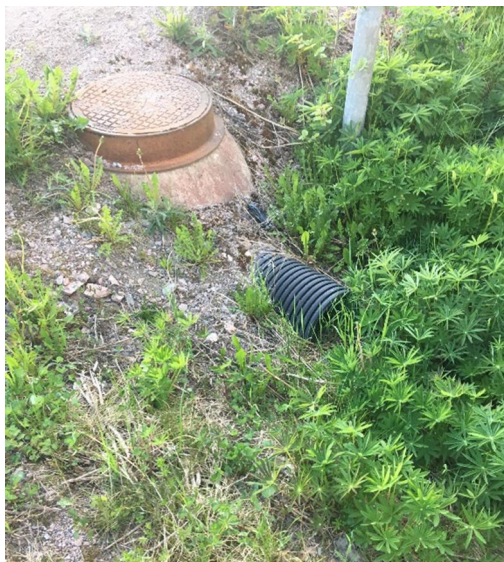
Figur 8. Brunn i dike vid korsningen Järnavägen/Källbacksvägen.
