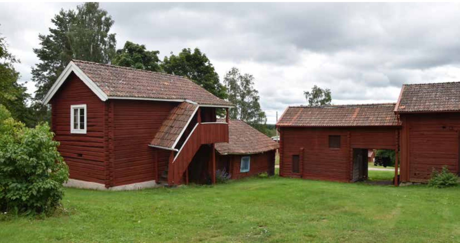
Ålderdomliga ekonomibyggnader, bland annat en källarstuga. Äldre kringbyggda gårdar innefattar en mångfald av timmerhus med olika funktioner, storlekar och höjder anpassat därest. Hälla 5:10.
