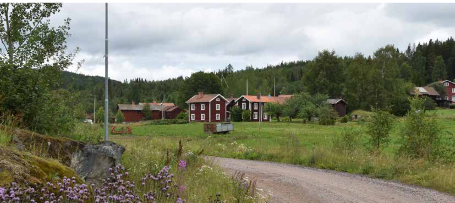
Två höga enkelstugor med flacka sadeltak på en gård i Hälla. Byggnaderna har lunettfönster vidnock, vilket är vanligt på äldre bostadshus i Hälla och andra Dalälvsbyar. Nästan alla hus i byn är dessutom röda, långsmala och med sadeltak. Hälla 18:3.
