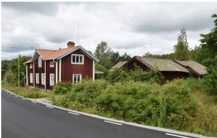
Kringbyggd gård med framträdande parstuga och bevarade äldre ekonomibyggnader i timmer. Gården är kringbyggd på tre sidor. Hälla 30:3.
