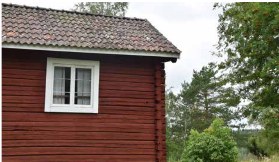
Blyspröjsade fönster förekommer på vissa gårdar och är ett ålderdomligt karaktärsdrag. Hälla 5:10.
