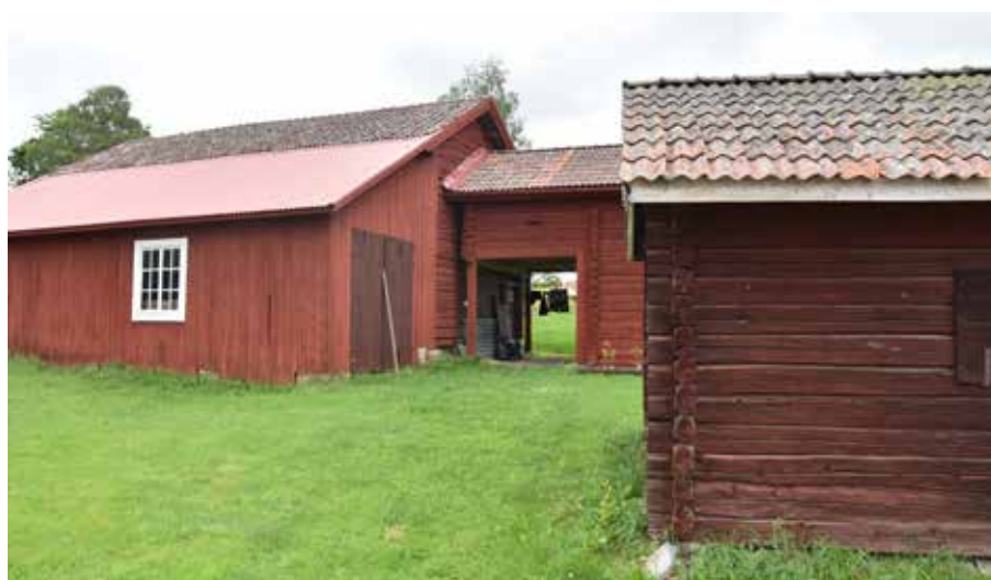
Kringbyggd gård med ålderdomliga timmerhus, exempelvis ett portluder som leder in mot gårdstunet. Hälla 5:10.
