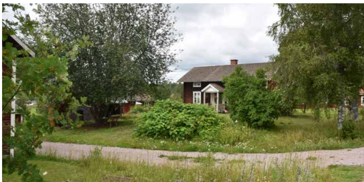
Samma byggnad från framsidan i söder. Den enkla utformningen går igenom även i exempelvis utformningen på farstukvist och skorstenen. Hälla 13:13.
